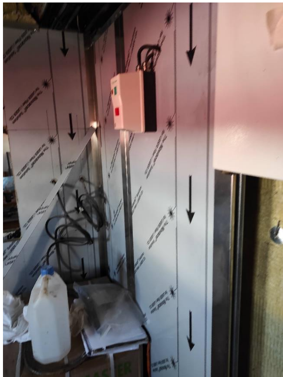
(στ) Εφαρμογή ανοξειδωτων ελασμάτων επενδύσεως κουζίνας
