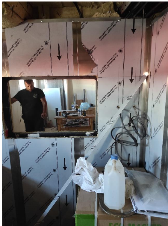
(στ) Εφαρμογή ανοξειδωτων ελασμάτων επενδύσεως κουζίνας
