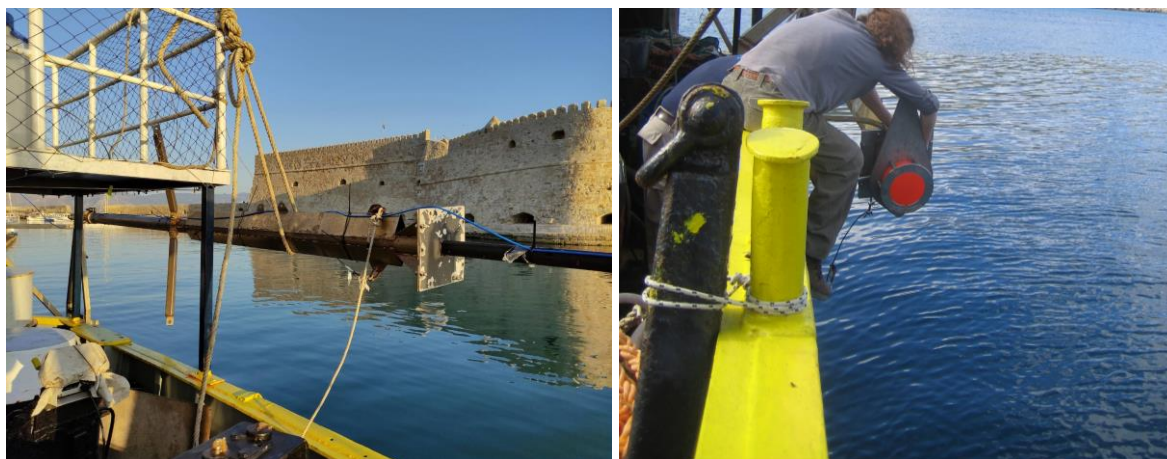
Εικόνα 1. Φορέας & εγκατάσταση μεταλλάκτη στην πλευρά του Ε/Σ ΦΙΛΙΑ.
